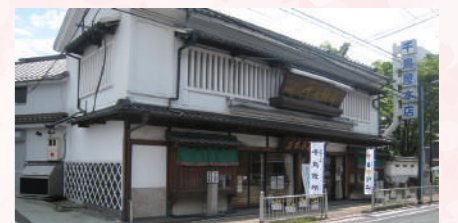
〈店舗改修前の千鳥屋本家 本店〉
